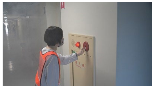
消火栓の発信機ボタンを押す第一発見者
